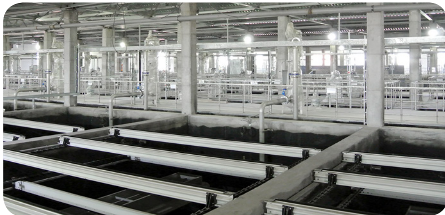
DAF-kotrók teljes mértékben műanyagból
