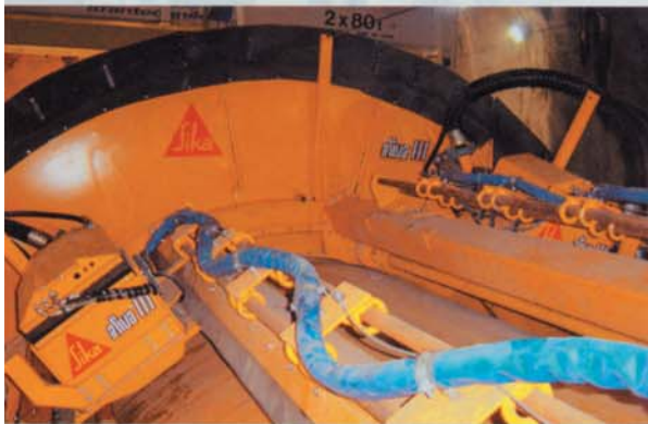
Betonlövő robot egysége az alagútfúró berendezésen, pajzson (TBM)
