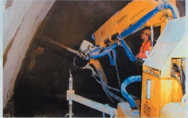
Aliva®-503 betonlövő rendszer alkalmazása kisebb szekciók esetében
