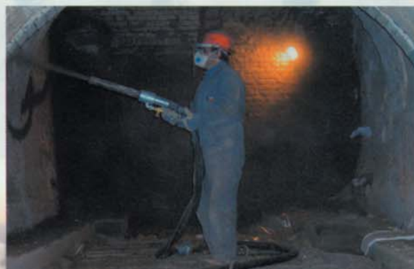
Alagútfal javítási munkálatai
