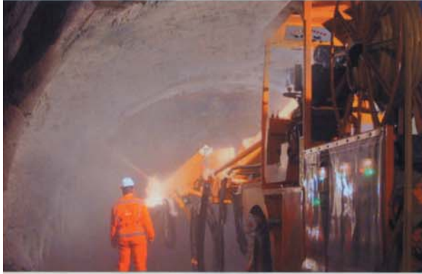
Sika®-PM500 betonlövő rendszer alkalmazása nagyobb szekcióknál
