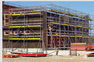
Állványok betonacél szereléshez
