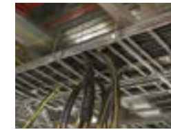
Kábellétra: a fő elosztási infrastruktúra
