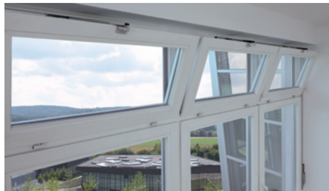
Manuelle oder motorische Betätigung zur Lüftung: VENTUS
