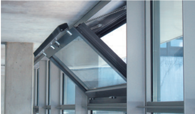
Kettenantriebe sorgen für perfekt dosierte Raumlüftung mit großen Öffnungsweiten bis zu 1000 mm
