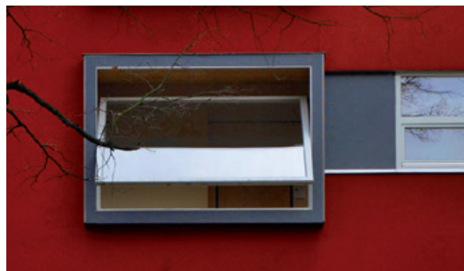
Schwingfenster für Flügelgewichte bis 300 kg
