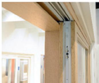
Der HS ePOWER wird durch einen Stromüberträger gespeist, der im geschlossenen Zustand die im Flügel eingebauten Akkus automatisch auflädt. Die Akkulaufzeit ist so ausgerichtet, dass ein Offenlassen der Tür selbst über viele Stunden die Funktionalität nicht einschränkt und diese auch bei Stromausfall gewährleistet.
