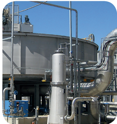
Kiemelkedő teljesítményű szaturációs rendszer, amellyel mikrobuborékok hozhatók létre és juttathatók be a flotálómedencékbe
