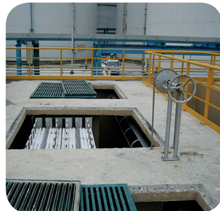
CPI – telepítés medence fedéssel
