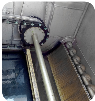
DAF kotrórendszer; rámpa és szállítócsiga segítségével történő iszapeltávolítás
