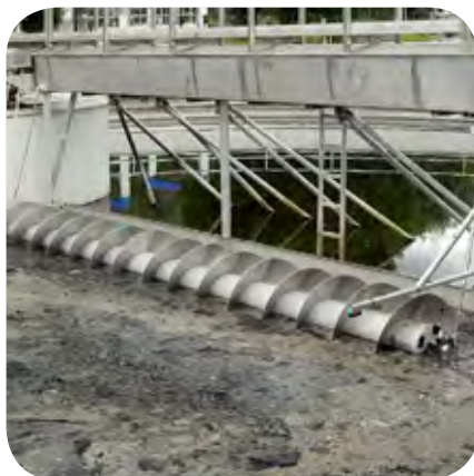
Szabadalmaztatott uszadék kihordócsiga koncentrikus úszó elszívó üzeme
