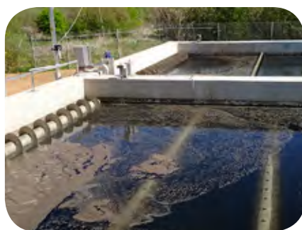
Négyzetletes medencék víz alá süllyesztett csövekkel és kihordó csigákkal az uszadék eltávolításhoz
