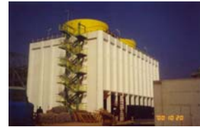
Betonjavítás – SikaMono Top
