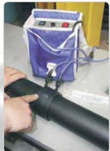
hegesztési művelet befejezése, lehülési folyamat
