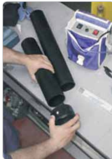
elektrokarmantyú felhelyezése
