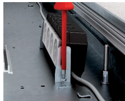
Szerelvények hely és modul tartó beszerelése csatorna alsó részbe Az installációs szerelvények csatlakoztatása után szerelje fel a szerelvény tartókat a modul tartókra vagy szerelvények helyekre. A komplett egységet fixen csavarozza be a csatorna alsó részbe.
