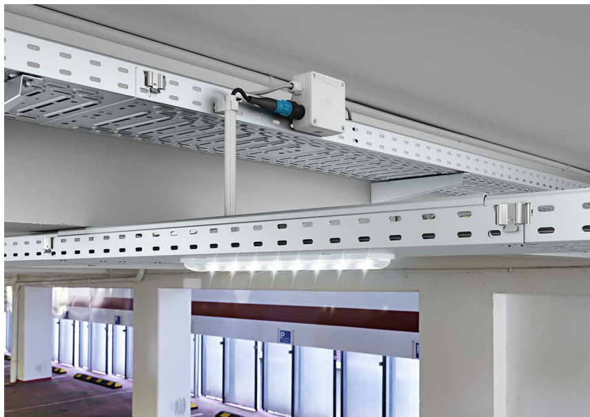
3 kép: 2+3. típusú túlfeszültség-védelmi eszköz, ÜSM-LED 230, leágazódobozban, a kábeltartó-szerkezeten rögzítve,
