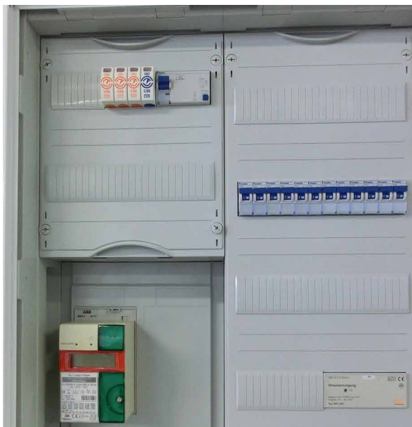
1 kép: 1+2. típusú túlfeszültség-védelmi eszköz, V50 3+NPE-280, főelosztóban
