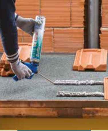
Tetőcserepek ragasztása cseppekben alkalmazott termékkel
