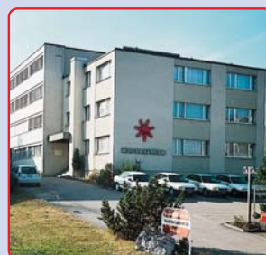
Svájc HELIOS Ventilatoren AG Urdorf/Zürich
