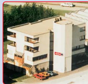
Ausztria HELIOS Ventilatoren Ges.m.b.H. Innsbruck
